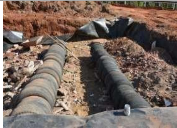
Figura 3b – Instalação dos pneus formando câmaras de recebimento de efluentes.
