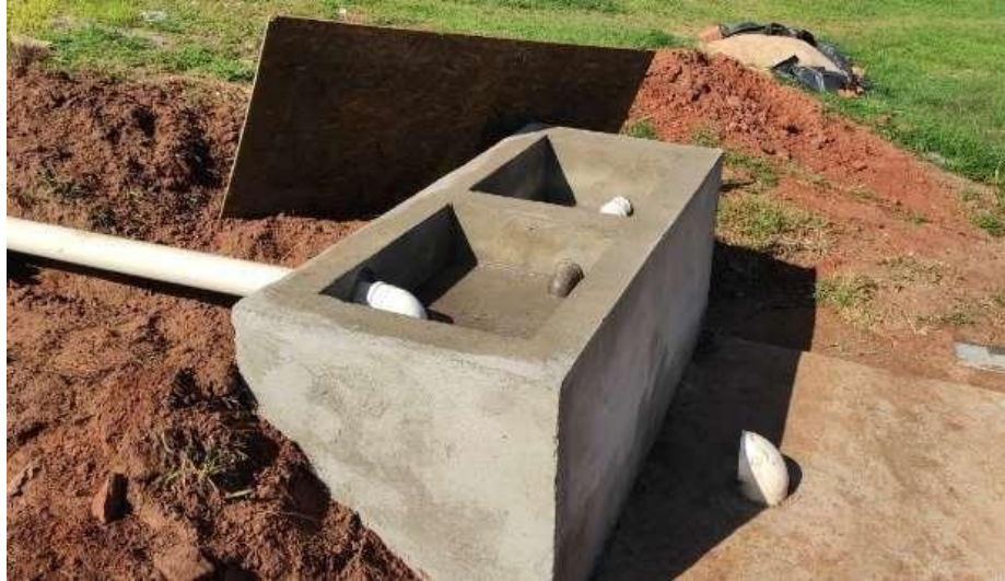
Figura 4: Caixa de gordura em alvenaria.
