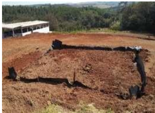
Figura 3e – Bacia de evapotranspiração concluída e camada de solo sobre a areia.
