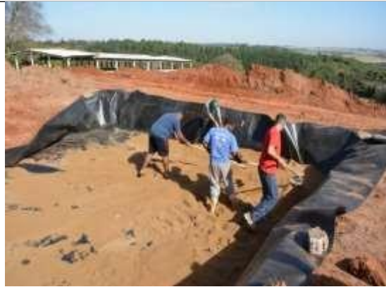
Figura 3a – Geomembrana e preparo com areia grossa para receber o entulho.
