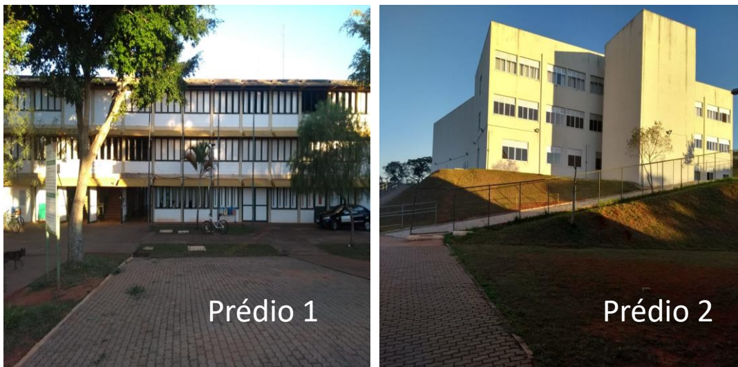
Figura 1. Fotografia dos prédios do IF Sudeste- Campus São João del Rei.
