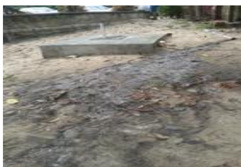
Figura 1- Águas servidas despejada na praia.
