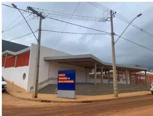
Figura 4 – EMBR reconstruída no reassentamento de Bento Rodrigues
