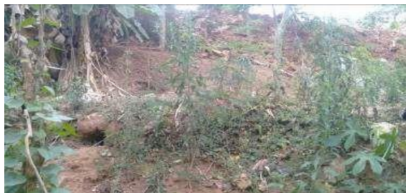
Figura 4. Vista parcial da voçoroca com presença de resíduos sólidos e bananeiras em suas margens.
