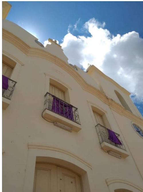
Figura 05 – Guarda-corpo de ferro forjado na fachada frontal
